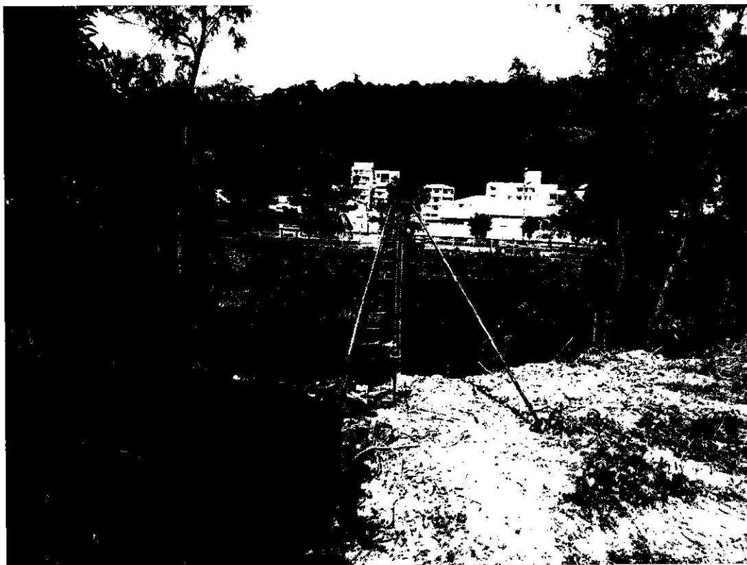
IMG01 – Execução SP01
